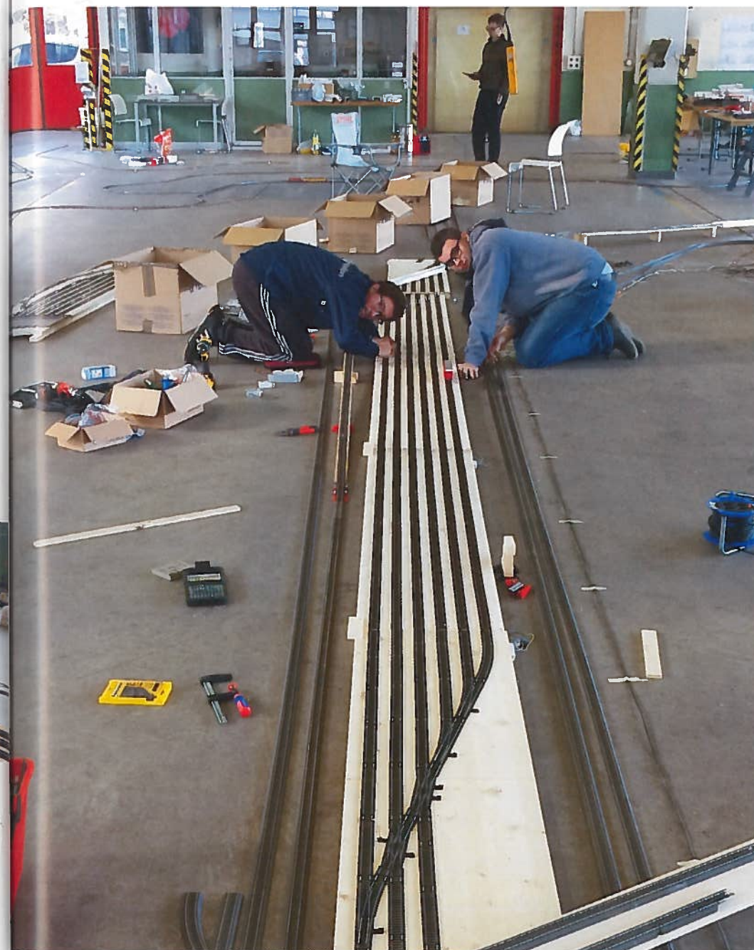
Vorgefertigte Module und Steuerungen erleichtern den Aufbau. In Planung sind ein zehngleisiger Kopfbahnhof und der Nachbau des Bahnhofs Wädenswil. Grenzen setzen dabei nur die Raumgrössen und das Budget. Im Bild: Abstellbahnhof für 4 Meter lange Züge.
